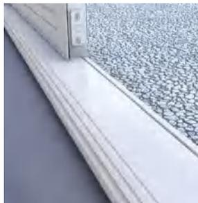
Nos portes de garage sectionnelles *Maori* sont équipées de série, d'un seuil aluminium de 20mm.
